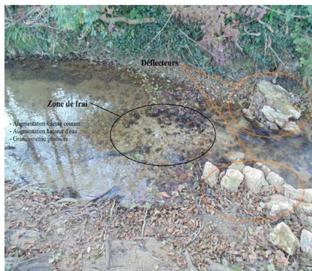
Figure 1 : Exemple de mise en place d'épis déflecteurs dans le cadre d'une restauration de frayère à truites sur la Vionne
